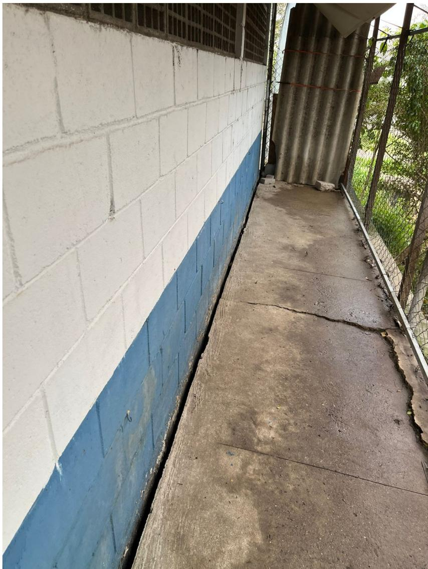
Foto 7. Passeio no perímetro da edificação com trincas e evidências de movimentação.
