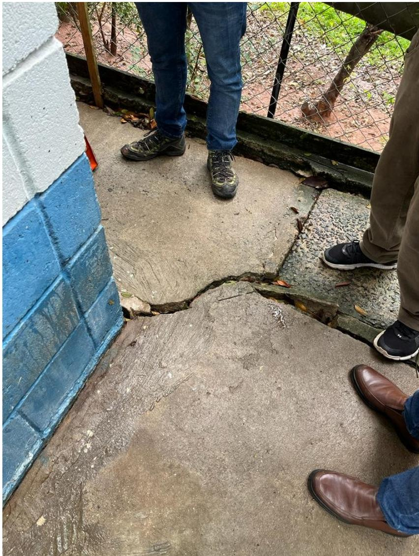
Foto 6. Passeio no perímetro da edificação com trincas e evidências de movimentação.
