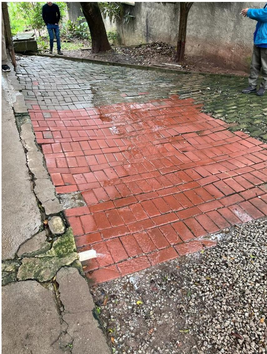
Foto 5. Solapamento de pisos na área externa.
